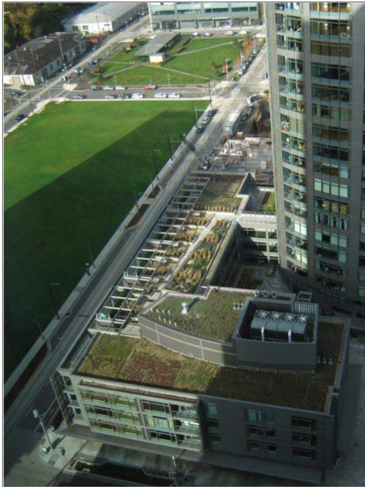
Toit vert extensif, Portland. Photo : N. Bédard
