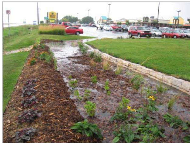
Bande filtrante près d'un stationnement commercial, Minnesota, Photo : Université du Minnesota.
