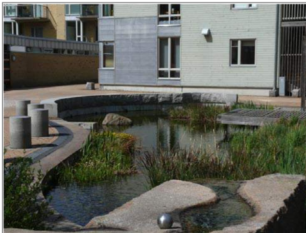
Marais filtrant en milieu urbain, Malmo, Suède. Photo : P. Stahre
